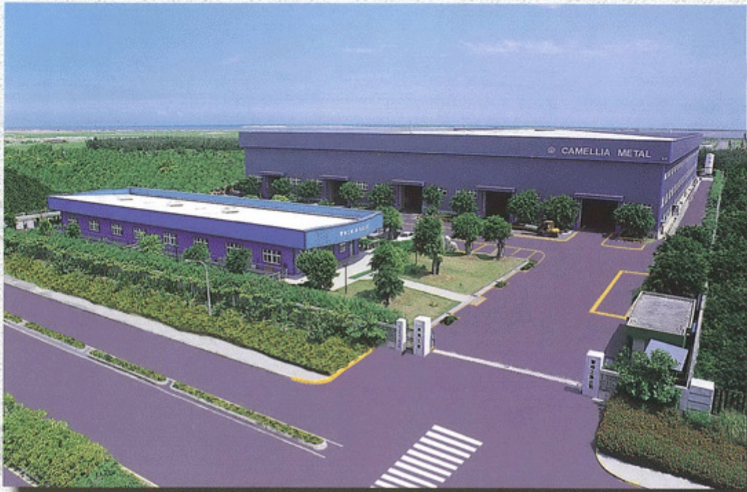
鹿港廠 (LUKANG WORKS)
